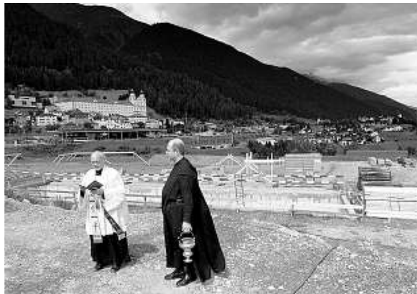
Auf gutes Gelingen: Abt Daniel Schönbächler und Pater Vigeli Monn (von links) erbitten den Segen für die Baustelle auf der Salaplauna. Bild Jano Felice Pajarola
