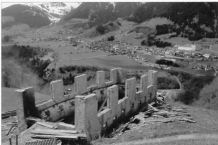
Rückbau des zerfallenden Stalles auf Bovan, anfangs Mai 2006
