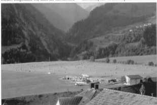
Der Pächterbetrieb Salapiana nach dem Brand des Ökonomiegebäudes
