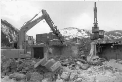
Rückbau der Brandruine mit mehreren Baggern, Trax und Recycling-Anlage.
